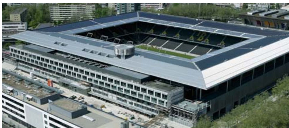
Flugansicht des Stade de Suisse Wankdorf Bern mit integriertem Sonnenkraftwerk und Info- und Meetingcenter «SOLEIL».
