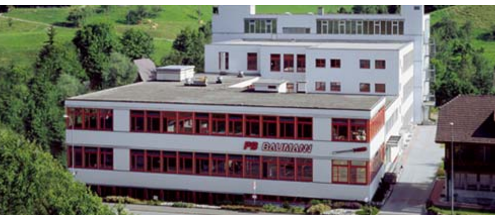
Der Hauptsitz der PB Baumann GmbH in Wasen
