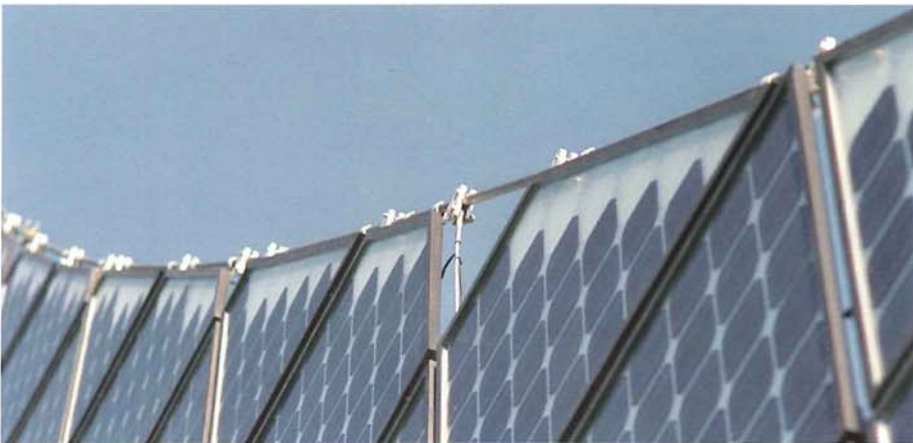
Mastspitze (oben links); Abspannung des Mastes (oben rechts); Transluzide Solarmodule unterschiedlichster Form und Grösse
